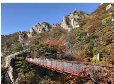
雲橋(クムダリ)・三仙階段・頂上(開拓塔)
